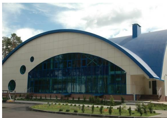
Теннисный корт в г. Югорск (ХМАО-Югра)
